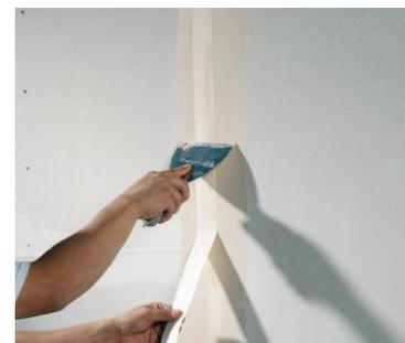
Die Fugenverspachtelung bei Erdbebenkonstruktionen sollte unabhängig vom Fugenspachtelmaterial **immer mit Kurt-Bewehrungsstreifen** erfolgen. Das um eine optimale Rissicherheit zu erlangen.
