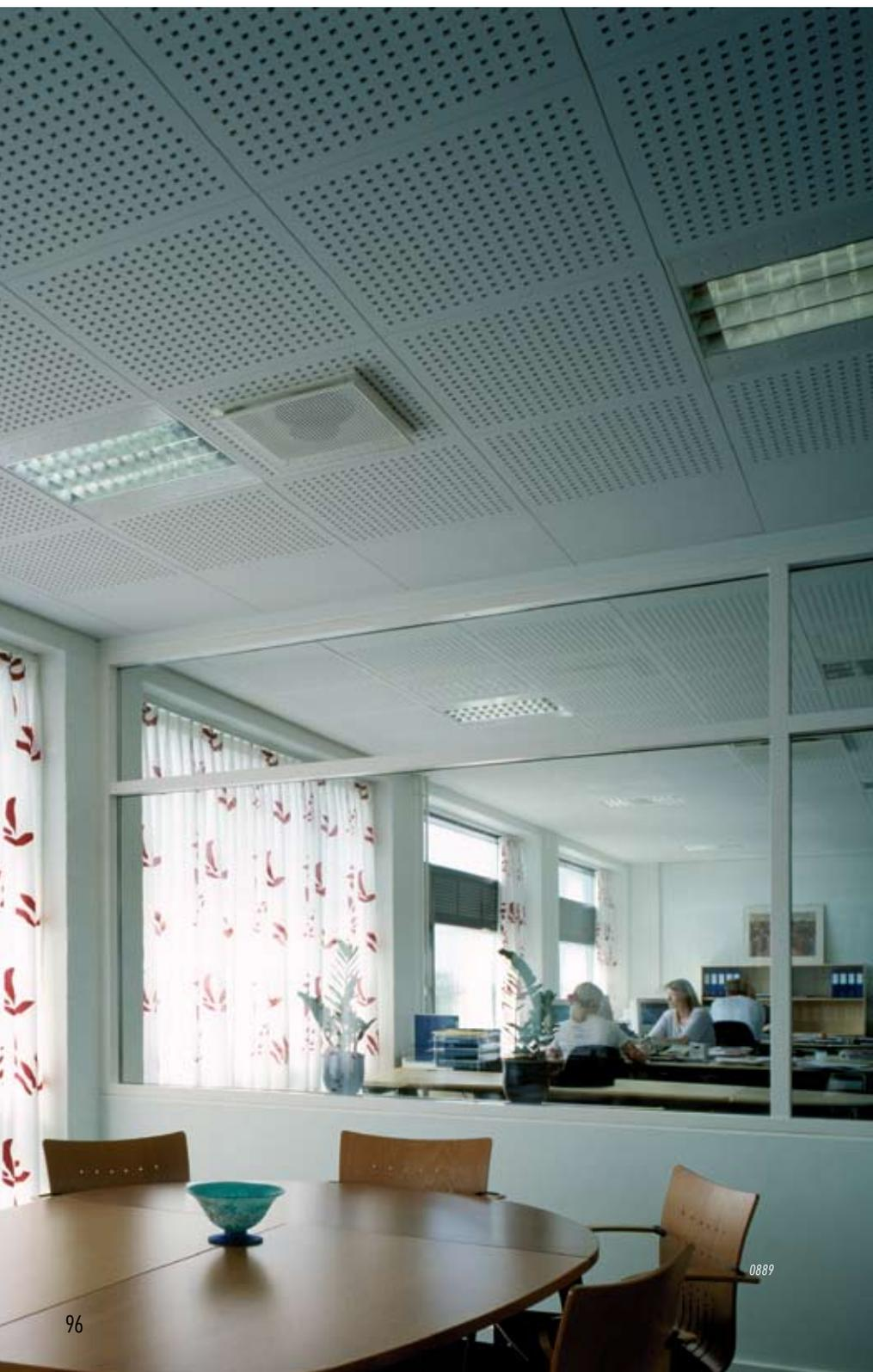
Die Forderung nach Schalldämmung wird aktuell, wenn der Wunsch nach einer durchgehenden Deckenkonstruktion mit einer unter der abgehängten Decke liegenden Zellaufteilung in kleinere Raumeinheiten kombiniert werden soll. Diese Konstruktion bietet viele Wahlmöglichkeiten in Bezug auf Einbau und Versetzung von Wänden.
