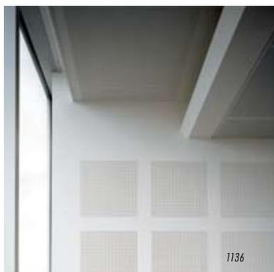
Faltelelemente bieten die Möglichkeit, mit scharfen und klar definierten Lichtkontrasten zu arbeiten. Die aus einem V-Einschnitt bestehenden Faltungen sind von zwei Seiten her und in mehreren Winkeln montierbar. Die Gestaltung ist nur eine Frage der Definition: Man nehme ein Stück Papier, falte es und schon tun sich die vielen Möglichkeiten vor einem auf.
