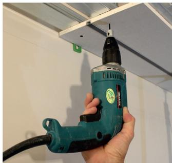
Fissare con viti gli elementi di base alla sottostruttura, come illustrato nelle sezioni D-D o A-A.
