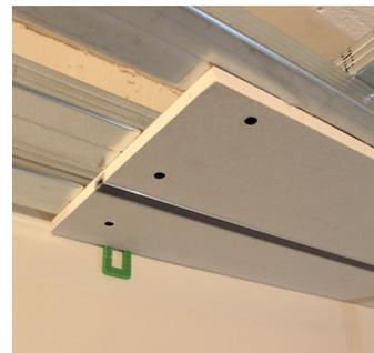
Inserire tre viti per la larghezza di ogni elemento, v. anche sezioni D-D o A-A.
