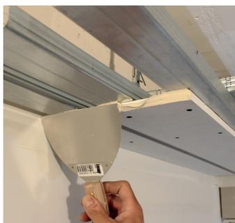
Prima di montare ulteriori profili di base in corrispondenza del giunto applicare Knauf Uniflott.
