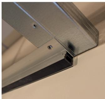
Montaggio su un lato, fissaggio con rivetti alla sottostruttura.
