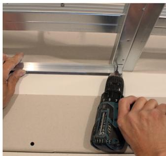
Montarlo su un lato, fissandolo con dei rivetti alla sottostruttura.
