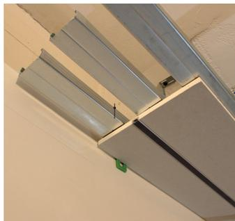
Montaggio profilo di base, distanza dalla parete 5-8 mm. Collegamento a parete con Trennfix 65.
