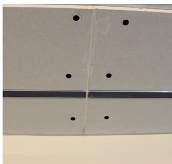
Esecuzione dei giunti; in corrispondenza dei giunti tra i profili di base applicare Knauf Uniflott nella fuga con l'ausilio della spatola.
