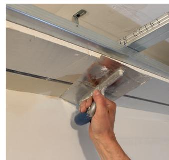
Superfici / Intonaco di finitura: si può applicare ad es. una mano di Knauf Finissimo Universal con un livello di qualità Q3 o Q4.
