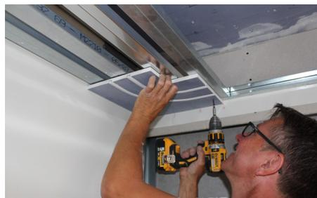
Montage Eck- oder Grundprofil-element, Abstand zur Wand 5-8mm
