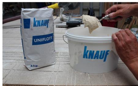
Für die Verbindung der Elemente Knauf Uniflott verwenden
