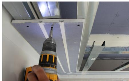
Gerade Vorhangelemente mit Schrauben XTN 33 x 3,9 mm in die Unterkonstruktion befestigen
