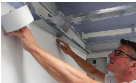
Beginn der Unterkonstruktion nach Datenblätter und Systemskizzen. Wandanschluss mit Knauf Trennfix 65
