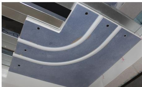
Eckprofile mit Schrauben XTN 33 x 3,9 mm in der Unterkonstruktion befestigen
